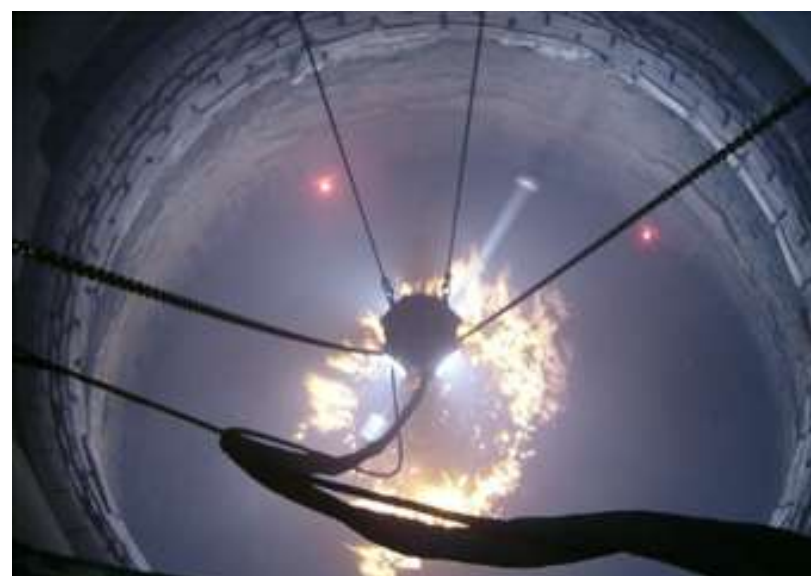
Shotcrete robotizado Robot shotcrete
