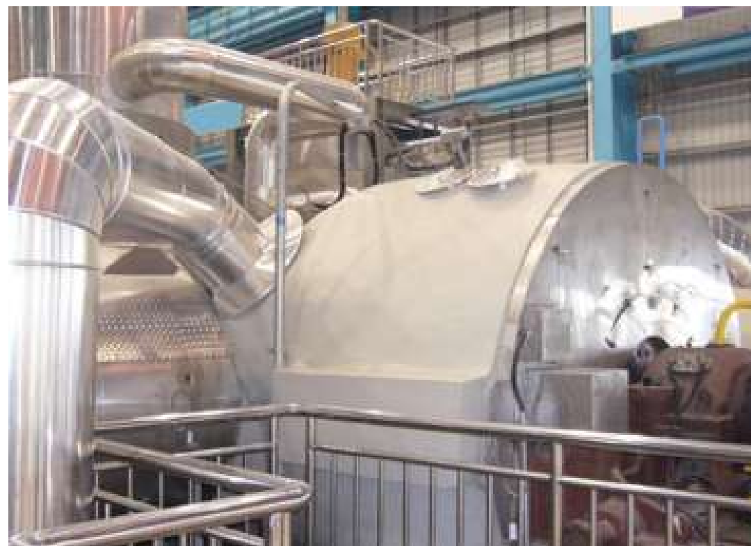
Isolamento térmico Thermal insulation
