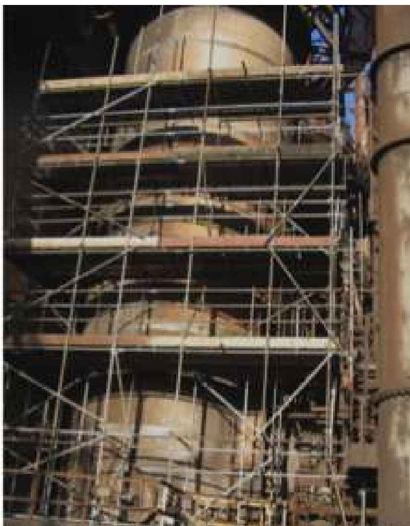
Montagem de andaime Scaffolding erection
