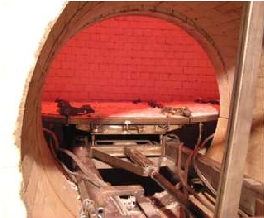
Reparo a quente Hot repair
