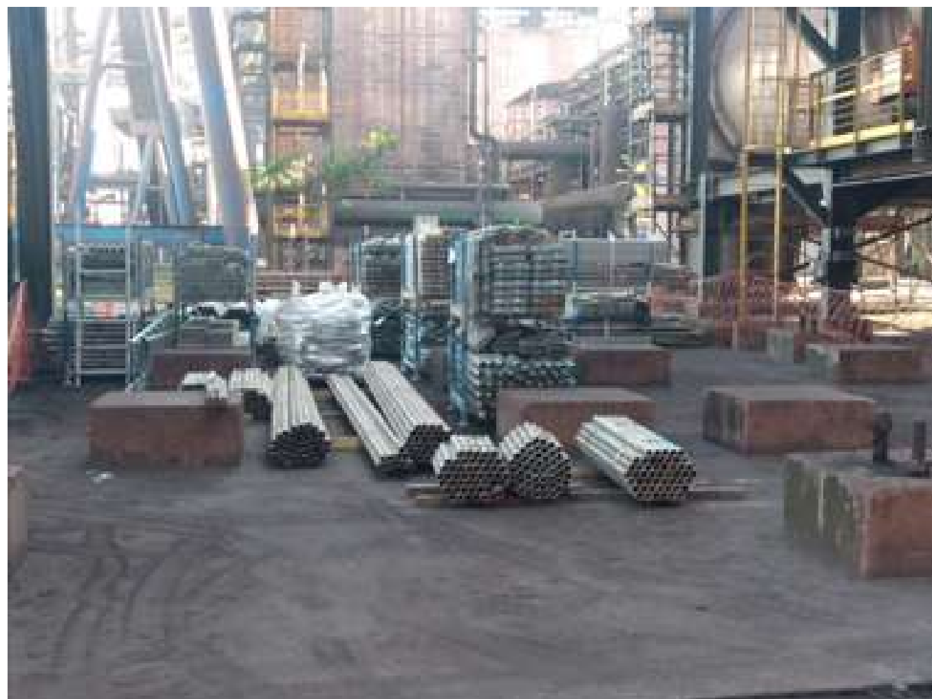
Montagem de andaime Scaffolding erection
