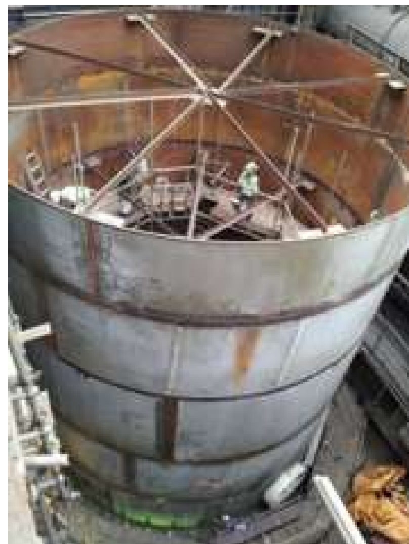
Montagem eletromecânica Eletromechanical erection
