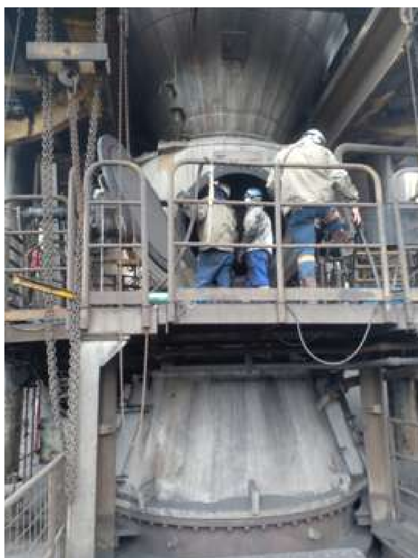
Reparo mecânico do topo do AF BF top furnace repair
