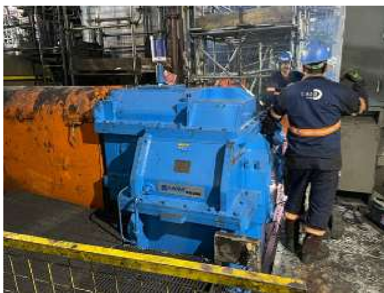
Manutenção de campo Filed maintenance
