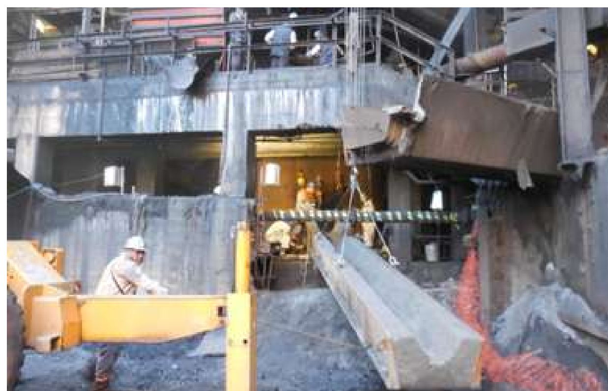
Reparo do Alto Forno - Vazamento de salamandra BF repair - salamander tapping
