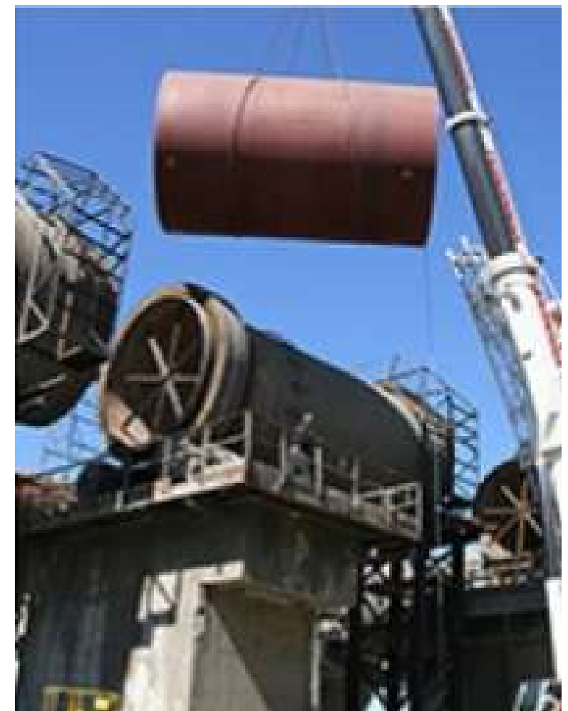
Indústria de cimento Cement industry
