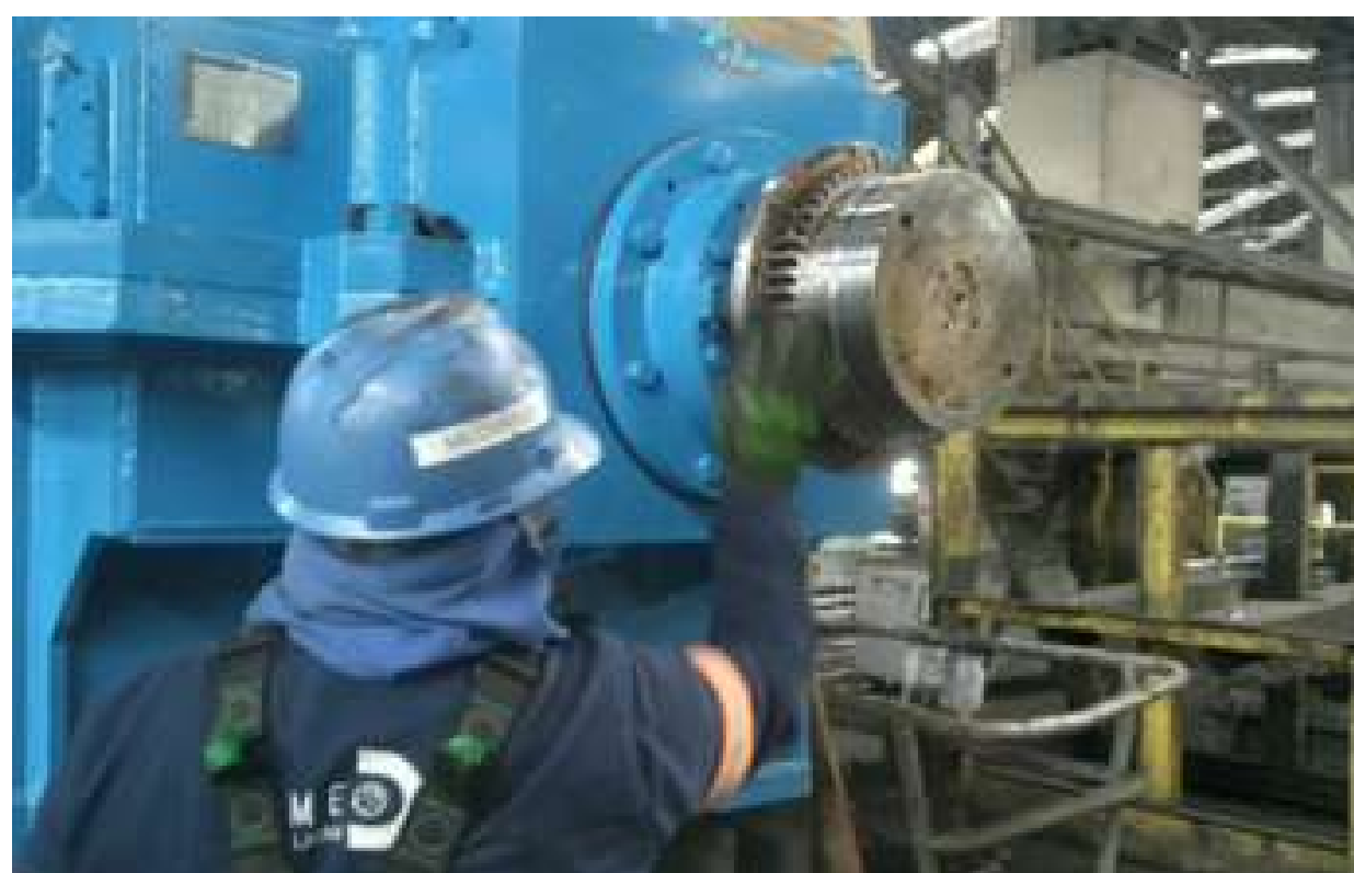
Manutenção de campo Filed maintenance
