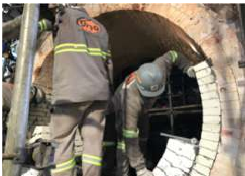
Montagem refratária Refractory lining
