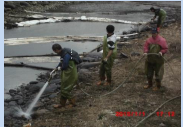
高壓沖洗機清洗河岸
