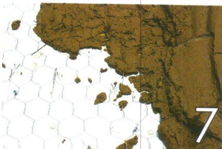
7 Vaciado de 4 cm de concreto sobre el machihembrado.
