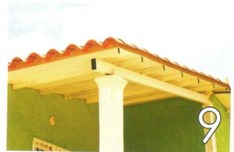
9 Al estar completamente seco se inicia con la instalación de manto asfáltico y cualquier otro revestimiento decorativo.
