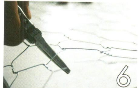
6 Colocación de malla metálica, anclada con tornillos.
