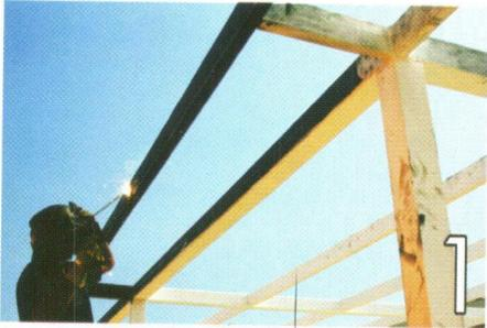
1 Se ensambla las correas en tubería estructural de 1x2 pulgadas en una distancia de 50 cm entre cada tubo.
